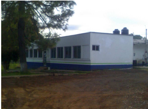
Edificio principal del Centro de Salud en Ziracuaretiro Michoacán, vista desde el estacionamiento.
