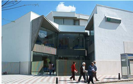
Fachada principal del Centro de Salud de Cabra, (Foto 1)
