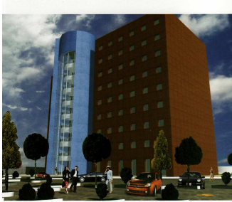
Vista de la fachada posterior
