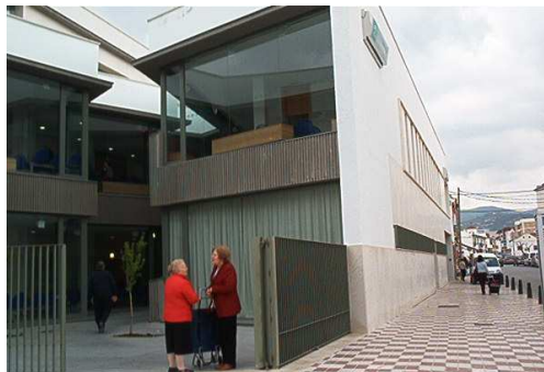
Fachada principal del Centro de Salud de Cabra, (Foto 2)
