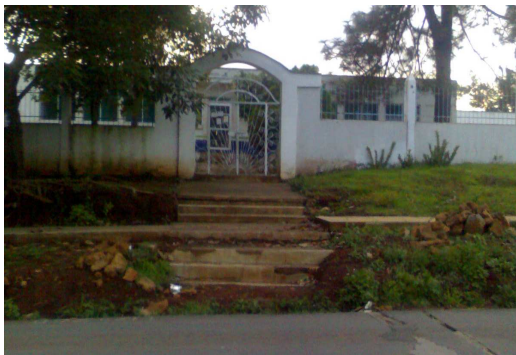
Fachada principal del Centro de Salud en Ziracuaretiro Michoacán, vista desde la carretera Taretan-Ziracuaretiro
