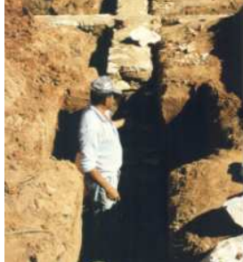
Sistema constructivo a base de mampostería de piedra para cimentación.
