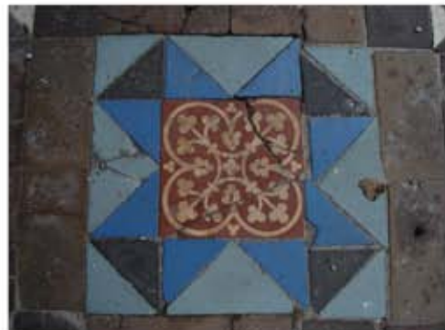
Piso de la cocina
