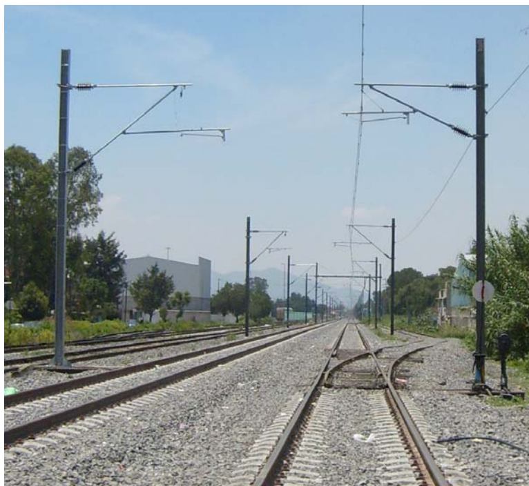
Figura 1.2.17: Postes y ménsulas del tramo Tultitlán – Cuautitlán (en obra). Foto tomada por Marcos Peña para este trabajo.
