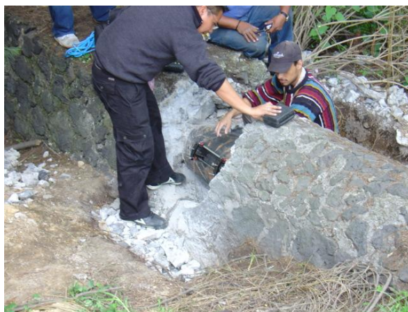
Figura 37. Colocación de medidor para medición de pérdidas en los Sectores Hidráulicos de Ciudad Universitaria.
