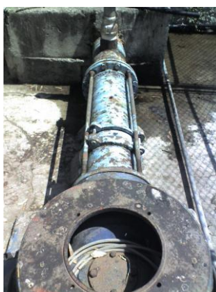
b) Pozo Multifamiliar
