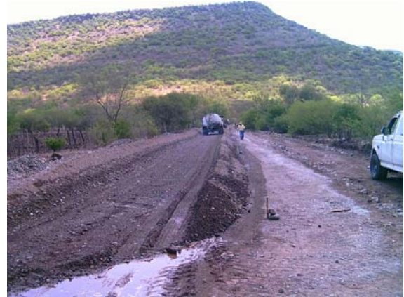
Imagen 5.3.tendido de base cementada.
