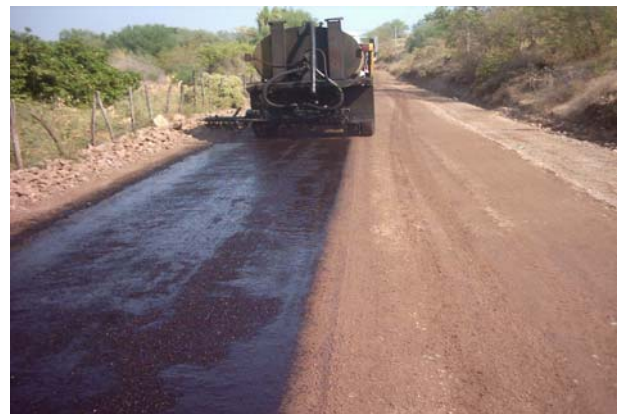
Imagen 5.4. Aplicación del riego de impregnación.
