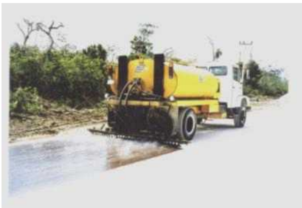
Imagen 5.4. Aplicación del riego de impregnación.
