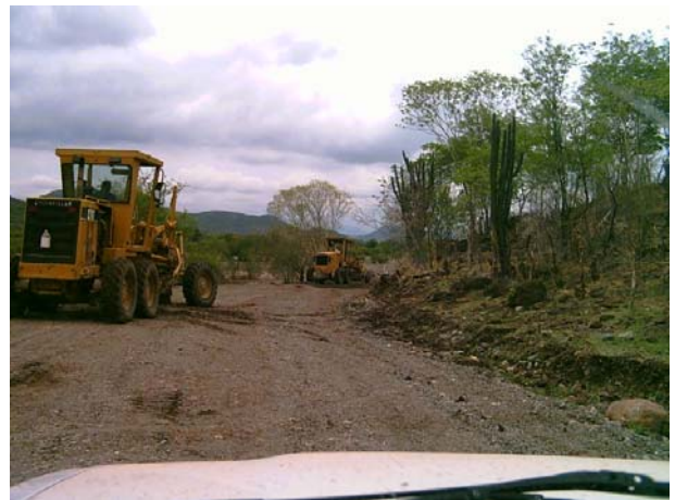
Imagen 5.3.tendido y compactado de base cementada.
