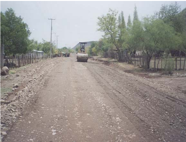
Imagen 5.3.tendido y compactado de base cementada.
