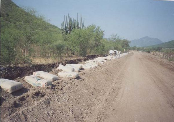
Imagen 5.3.tendido de base cementada.
