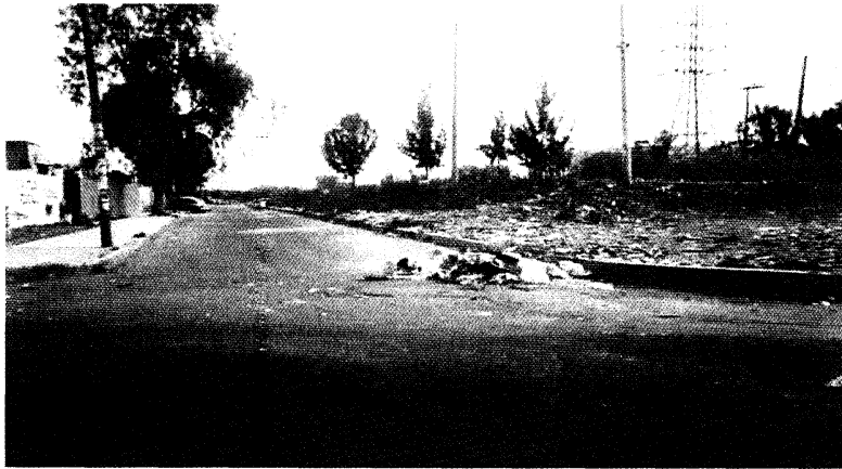
Fig. 51 vista exterior del lado poniente del predio; cruce sur 27 y prol. Calle 29; Punto de circulación y depósito de eléctricas
