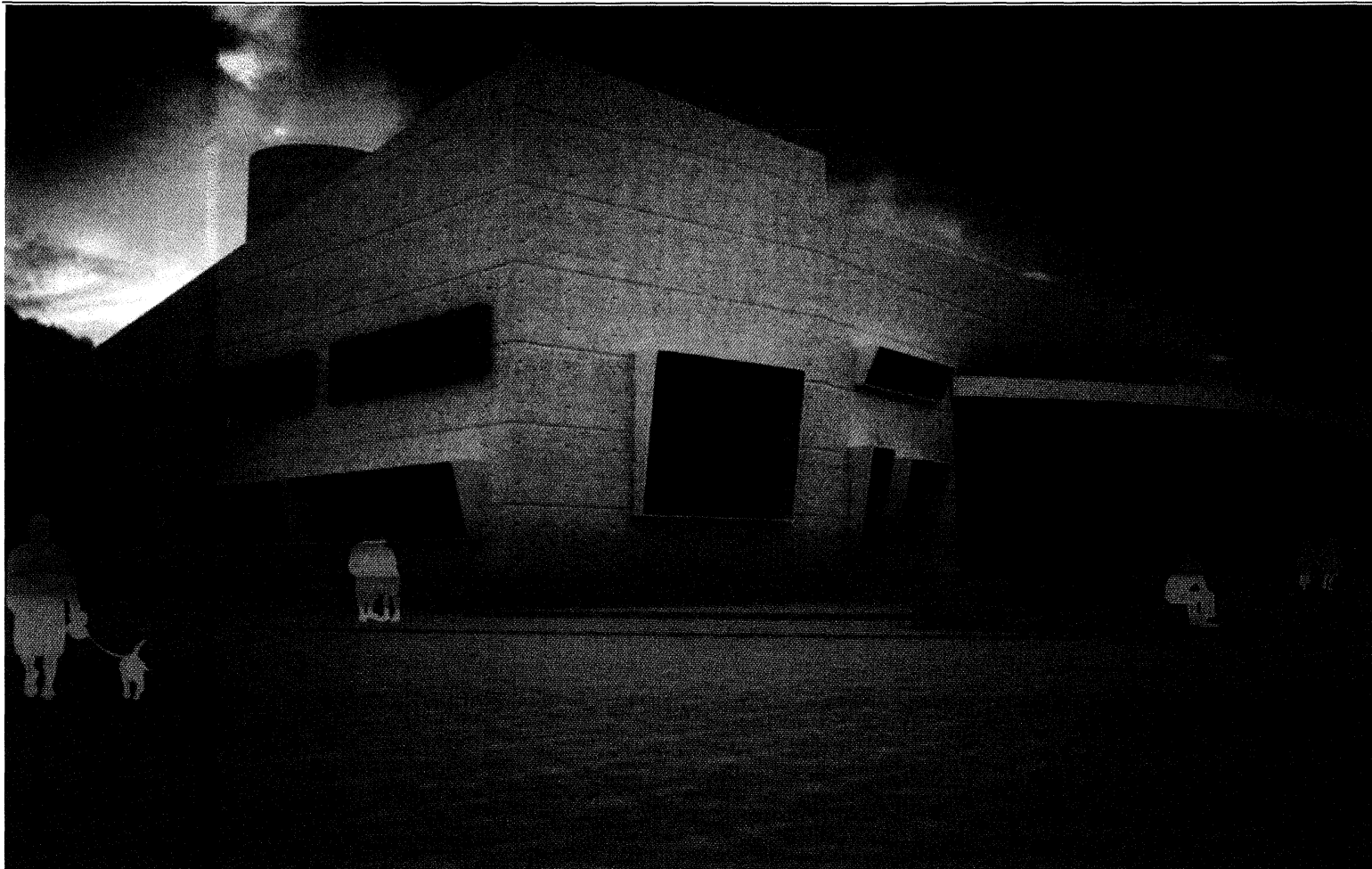
Vista de fachada Norte
