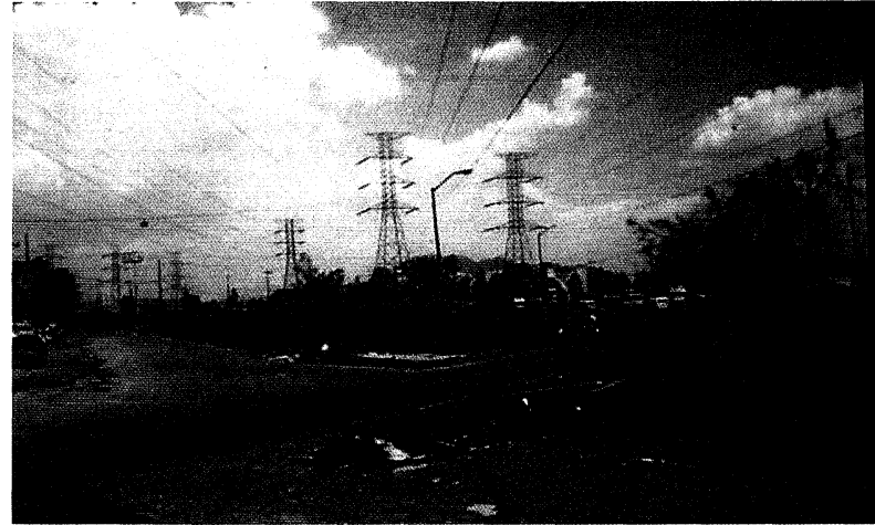
Fig. 52 vista exterior del cruce sur 27 y eje 6. Se observa el paso de instalaciones
