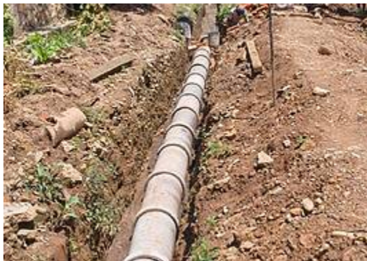
Construcción de drenaje sanitario en la Delegación de Tlalpan.
