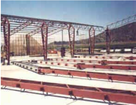
Sistema modular estructural.
