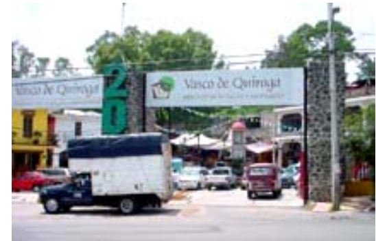
Vista fachada Mercado "Vasco de Quiroga".
