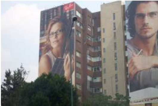
Imagen urbana dañada por la colocación de anuncios espectaculares.
