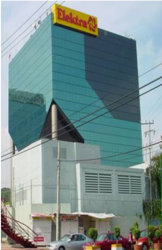
Fachada principal Torre Grupo Elektra.
