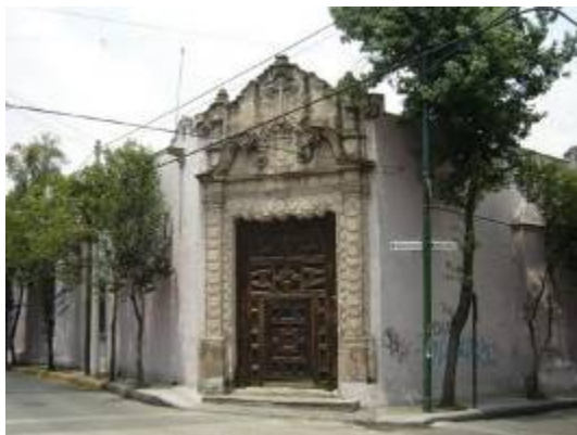
Casa Chata, fachada principal, delegación Tlalpan.
