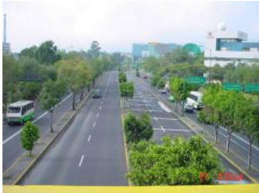
Corredor Urbano C-14- F, Avenida de los Insurgentes Sur.
