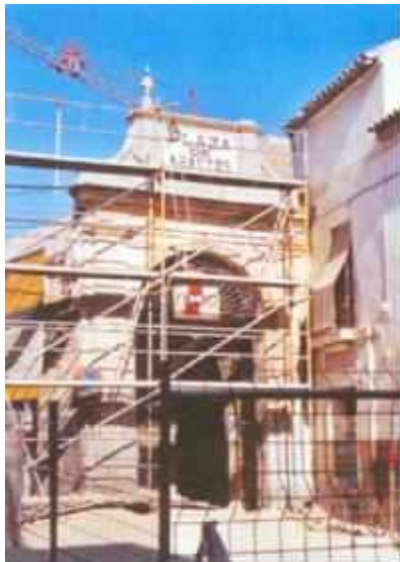
Foto 23. Puerta principal 9 de octubre del 2002.
