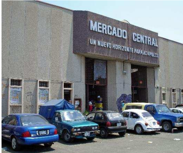
Foto 30. Aspecto de la remodelación de la nave siniestrada del Mercado Central.
