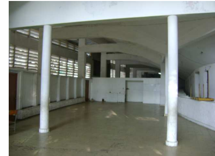
Foto 42. Interior del Edificio del antiguo Jai-Alai.
