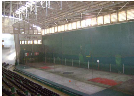
Foto 43. Interior del Edificio del antiguo Jai-Alai.
