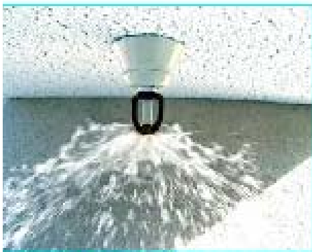
PIRINKLER BAJO PLAFOND
