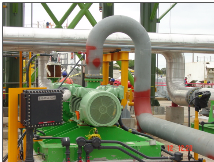
Fig.5.2.-Bomba de aceite de calentamiento.
