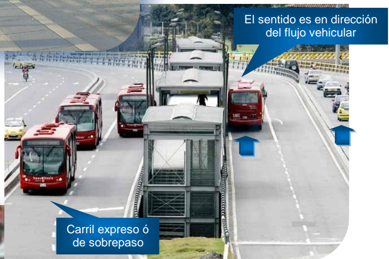
Imagen 1.11 Carriles semiconfinados en el Sistema Transmilenio ubicados en el separador central
