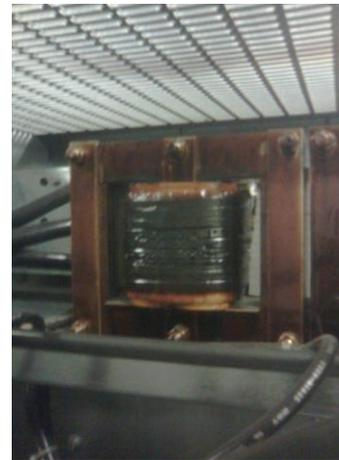
Filtro de entrada de un UPS, con presencia de corriente armónicas
