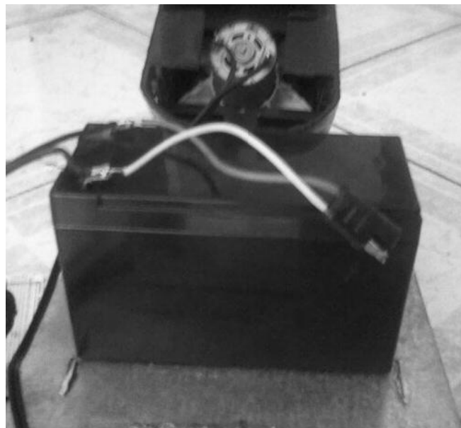
Fig.4.8. Colocación de la batería.
