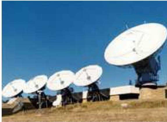
Fig. 1.4 Centro de transmisión de DirecTV en Castle Rock, Colorado (EEUU)
