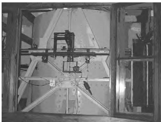
Figura II.1. Sismógrafo horizontal Wiechert de 1700 kg, 1910 (Fuente: <http://www.ssn.unam.mx/website/html/SSN/IMG/Instrumentos/est-mecanica1.jpg>)
