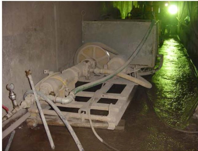
Fig. III.4.4 Instalación de bomba moino para prueba Lugeon y saturación del barreno
