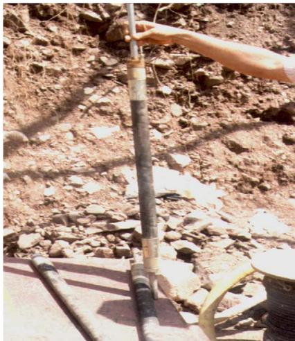
Fig. III.2.4.a Obturador de inyección
