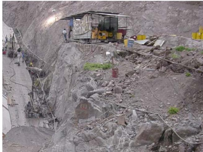
Fig. III.3 Planta de inyección (Plinto margen derecha)
