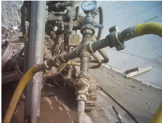
Fig. III.2.3 Manómetro en barreno de inyección
