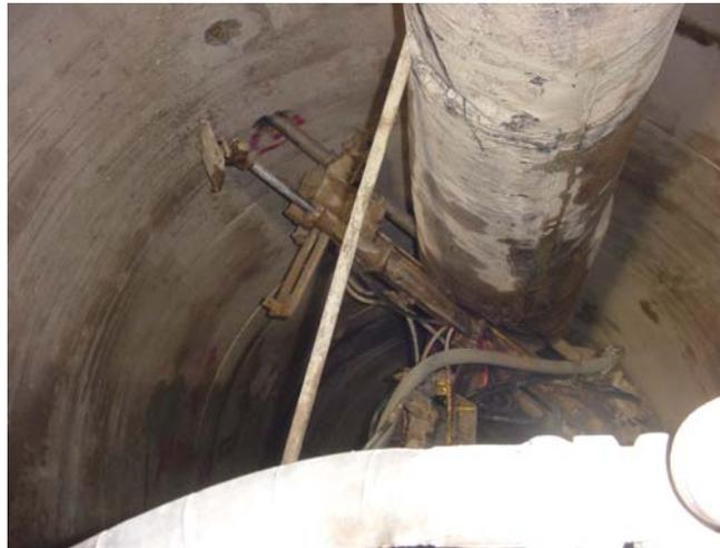
**Fig. III.4.3 Perforación de consolidación en galerías**
