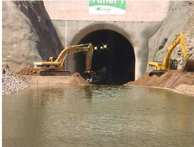
**Figura I.4.1 Túneles de desvío del río Santiago**
