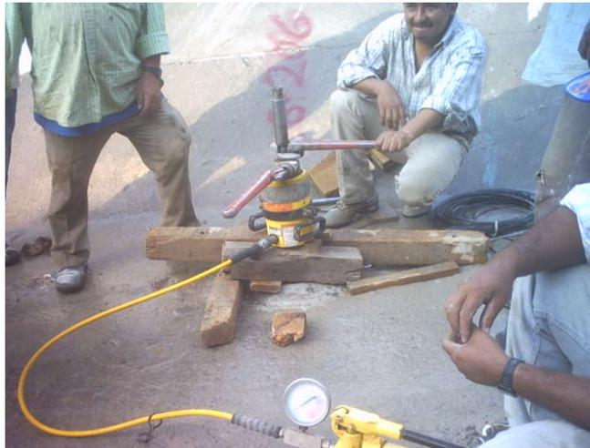
Fig. III.2.4.c Gato hidráulico para sacara al obturador atascado
