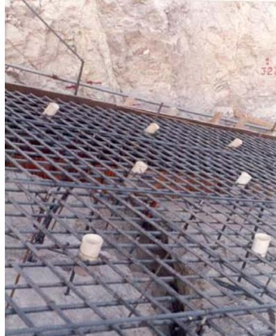
**Fig. III.4.2 Preparación para la perforación de barrenos en plinto**
