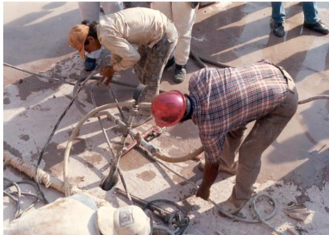
**Figura II.1.9 Colocación de tubería de inyección en barreno**
