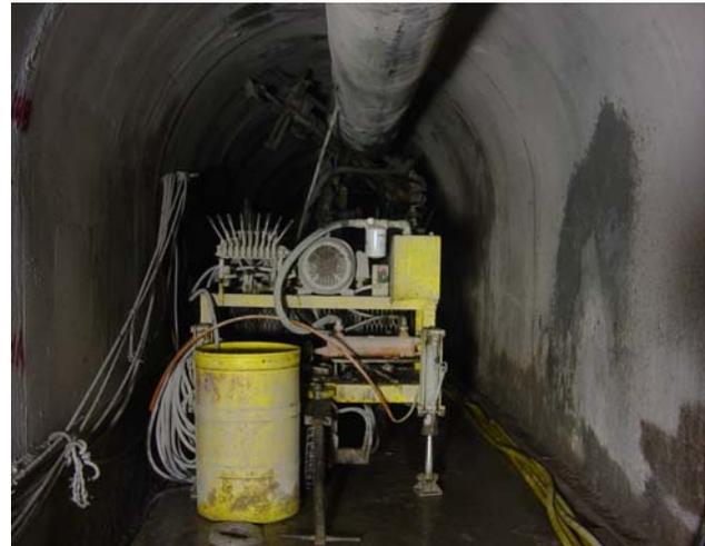
**Fig. III.2.6.b Core Drill**
