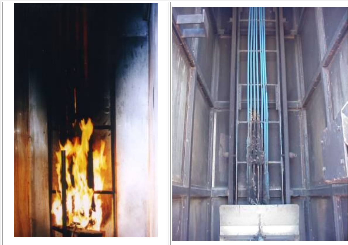
Cable convencional. No supera el ensayo de no propagación del incendio, todo el cable resulta dañado.
