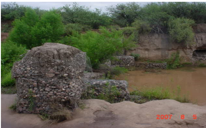
Foto 6: Gavión que no fue utilizado por el cauce del río. Fotografía de Anabell Pérez Flores
