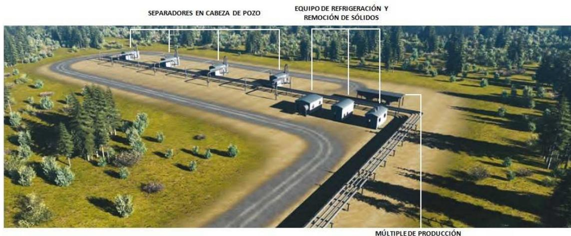
**Figura 5.7 Disposición de los pozos, (Petrobank Energy and Resources Ltd., 2006).**
