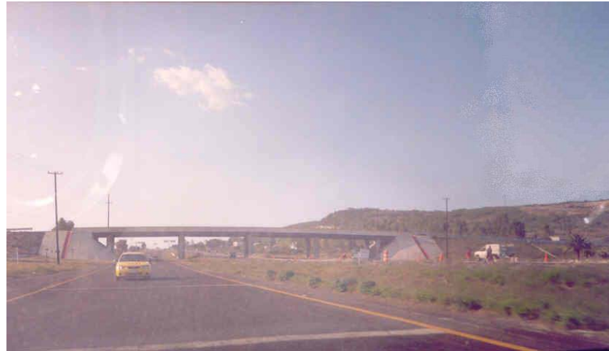
IMAGEN DE AUTOPISTA QUERÉTARO-CELAYA
