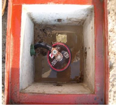
FIGURA 4.2 CONEXIÓN DE ELECTRODO DE TIERRA AL CABLE.
