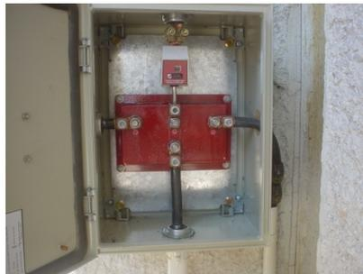
FIGURA 4.3 ACOPLADOR DE IMPEDANCIAS.
