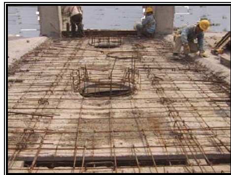
Figura 4.25. Refuerzo en capa de compresión.
