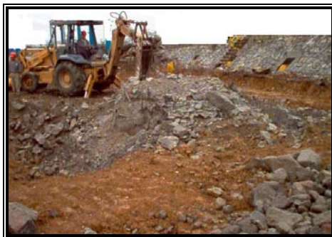
Figura 4.3. Limpieza del terreno.
