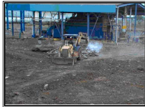
Figura 4.2. Demolición y excavación.
