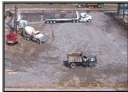
Figura 4.14. Perforación y colado de pilas.
