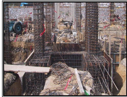
Figura 4.18. Refuerzo de dados-columnas.
