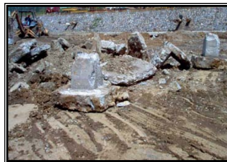
Figura 4.4. Extracción de cimentaciones.
