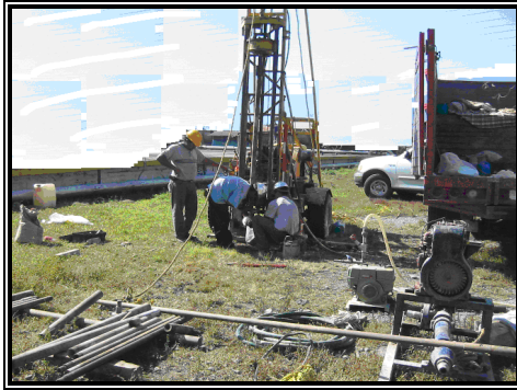
Figura 2.7. Realización del sondeo.
