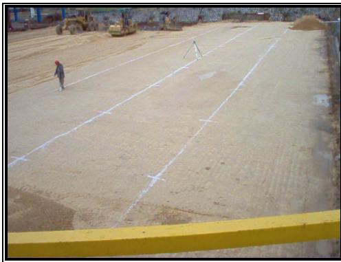
Figura 4.10. Nivelación de capa base.
