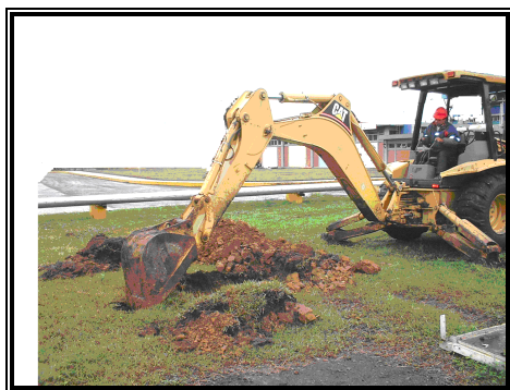
Figura 2.1. Trabajos de excavación.
