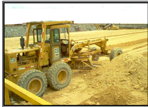
Figura 4.9. Tendido de capa sub – base.
