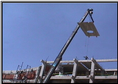
Figura 4.24. Montaje de losa prefabricada TT.
