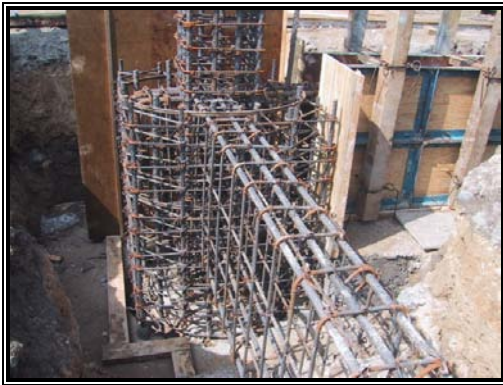
Figura 4.17. Refuerzo de traves de liga-pila-columna.
