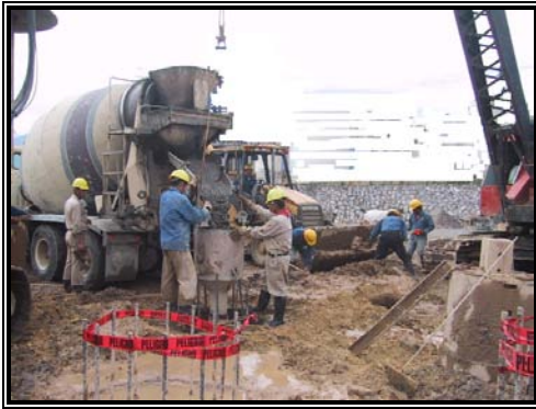
Figura 4.15. Colado de pilas.
