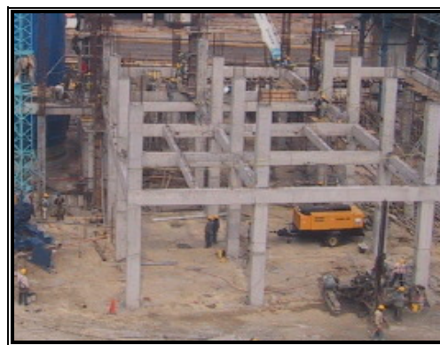
Figura 4.21. Columnas y trabes terminadas.
