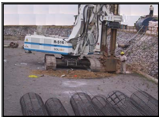
Figura 4.13. Perforación de pilas.
