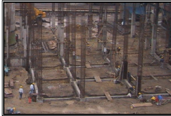
Figura 4.19. Distribución de refuerzo en columnas.
