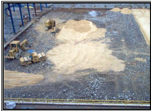
Figura 4.8. Tendido de pedraplén.
