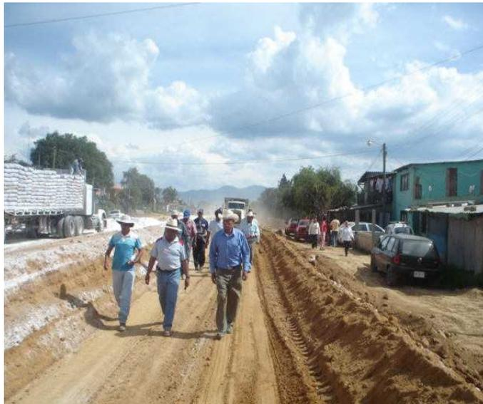
**Fotografía 4.7 Adición de calhidra para mejoramiento a nivel de subyacente km 1 + 964**
