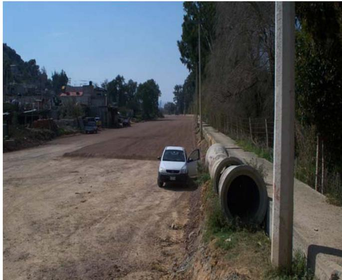
**Fotografía 4.8 Tendido de base a nivel de sub-base con con material procedente del banco los Migueles**
