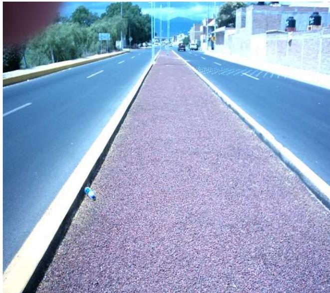
**Fotografía 4.14 Terminado de rasante para ciclo pista a base de gravilla roja del km 0 + 151 al 3 + 851**
