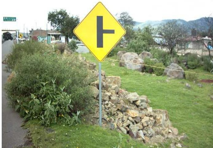
**Fotografía 4.24** Señalamiento preventivo indicando la intersección de tres ramas
