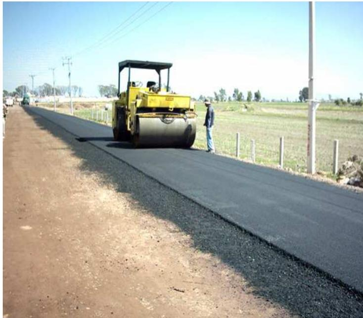
**Fotografía 4.12 Compactación de carpeta asfáltica por medio de rodillo**
