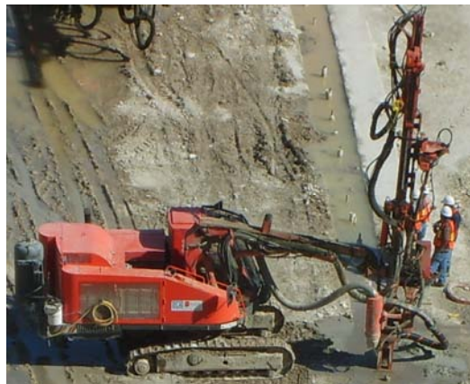
Foto 3.9. Equipo de Perforación.
