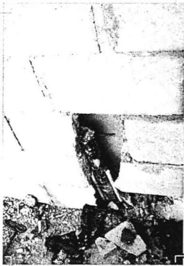
Colocación de plomería y electricidad sin ningún cuidado en la estructura de los muros
