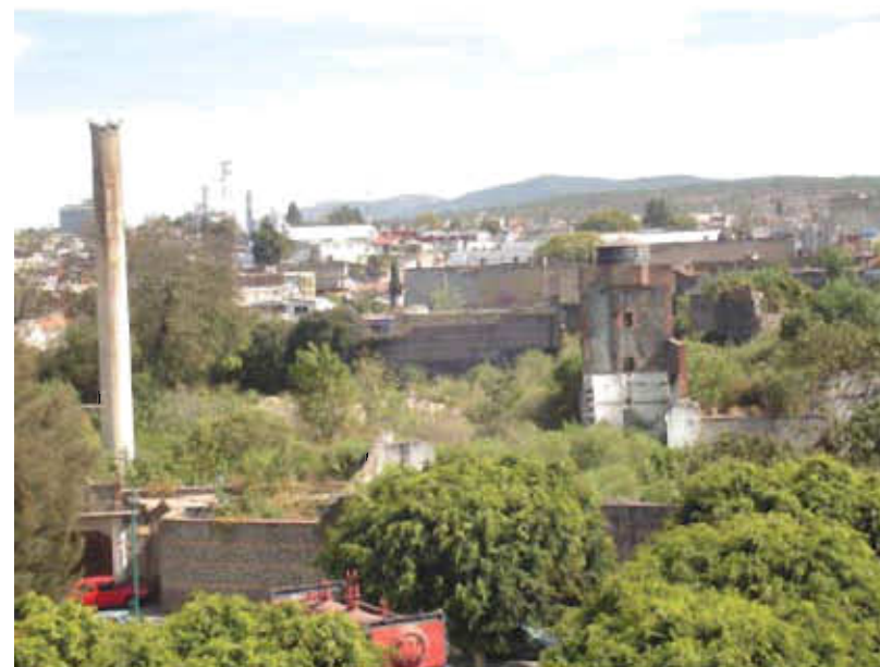
Interior de la Ex-fábrica, se observa a la izquierda el Chacuaco existente, a la derecha vemos el tinaco elevado, así como muros exitentes perimetrales.
