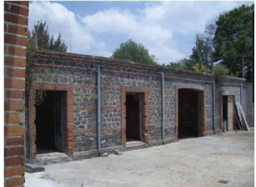
Muros mixtos existentes (piedra braza y tabique)
