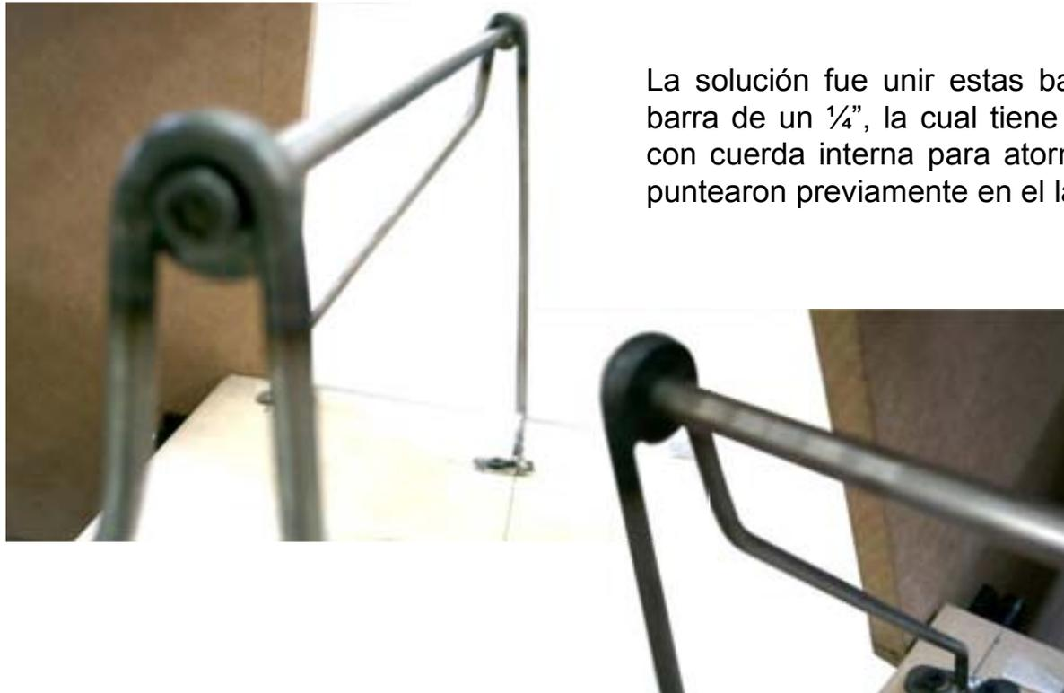
La solución fue unir estas barras por medio de una tercera barra de un  $\frac{1}{4}$ " , la cual tiene en los extremos unos barrenos con cuerda interna para atornillarla a unas rondanas que se puntearon previamente en el lado interno de las otras barras.
