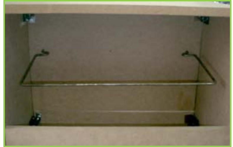
Se dobló una barra de acero 3/16" con la forma planteada en los renders, y se unió a la puerta, mediante unos barrenos donde entraban a presión los extremos de la barra.
