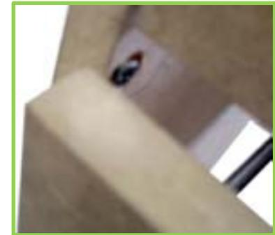
Se cambió el imán por otro con una fuerza adherente menor y éste se puso en la pieza lateral para hacer contacto con el canto de la puerta. En este caso resultaba muy débil y se abrían las puertas.
