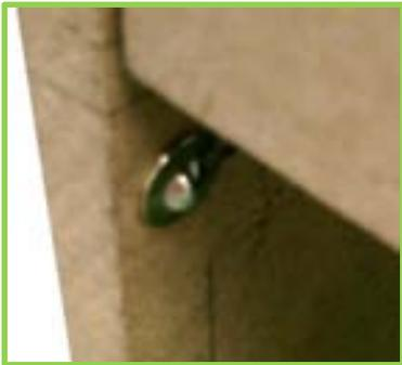
Finalmente, se hizo una prueba con un resbalón de bala para embutir de 1/2" con acabado tropicalizado, colocándolo en la pieza lateral para que atorara con el canto de las puertas. Este resbalón resultó ser una solución sencilla, económica y funcional.
