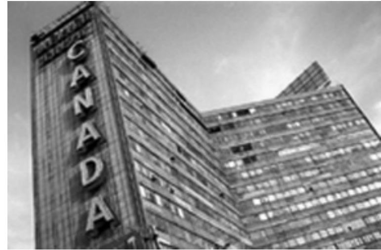
Fig. 2 y 3, Las letras que estuvieron colocadas en la fachada del edificio Ermita de las zapaterías Canada fueron desmanteladas y con el paso del tiempo estuvieron dispersas por diferentes lados, hasta que en el 2006 fueron rescatadas por el artista Ramiro Chávez, quien las expuso en la azotea del museo Carrillo Gil. Fuente: http://www.museosdemexico.org/img/fotos_exposicion/canada.jpg
