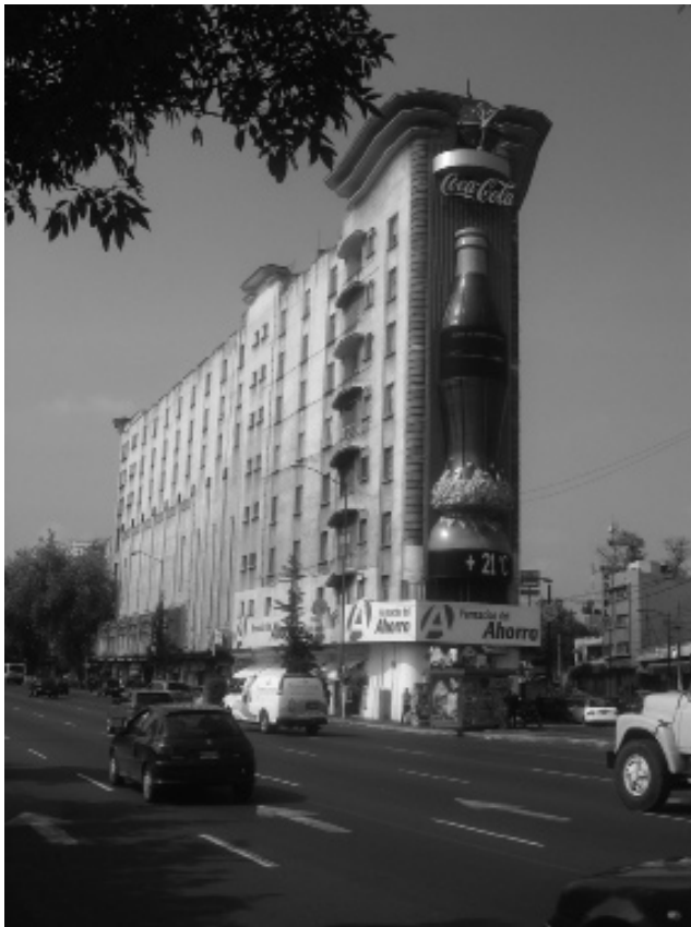
Fig. 26 Fotografía del Edificio Ermita del año 2007 Fuente: Fotografía del autor
