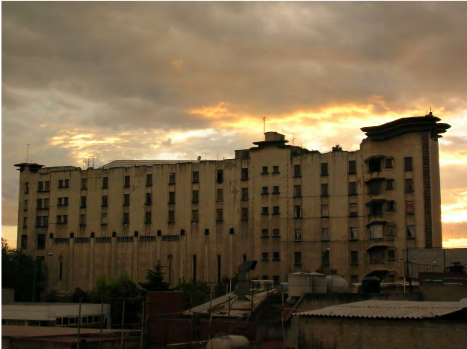
Fig.38 Vista de la fachada hacia el oriente, se dice que los alerones dieron al edificio la forma de avión, se manejaba este elemento para figurar ligereza y dar ese aspecto metafórico del avión.
