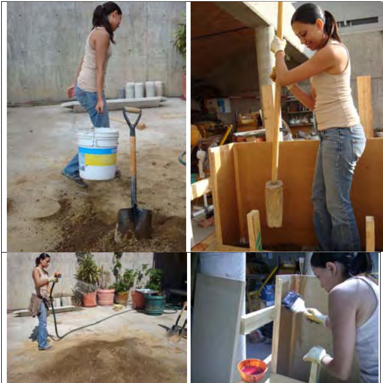
Imágenes arriba: cargando tierra y compactación con pisón manual, abajo: humedeciendo la tierra y dando tratamiento para humedad a encofrado de madera.
