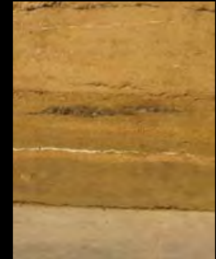
Muro de tierra experimental realizado por NCVM.
