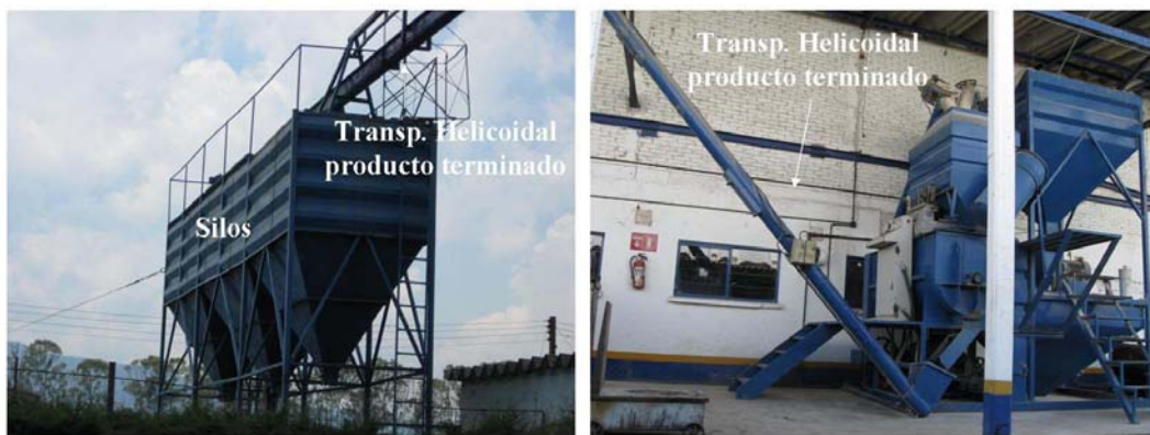
Transportador helicoidal producto terminado, Silos metálicos de recepción del producto terminado
