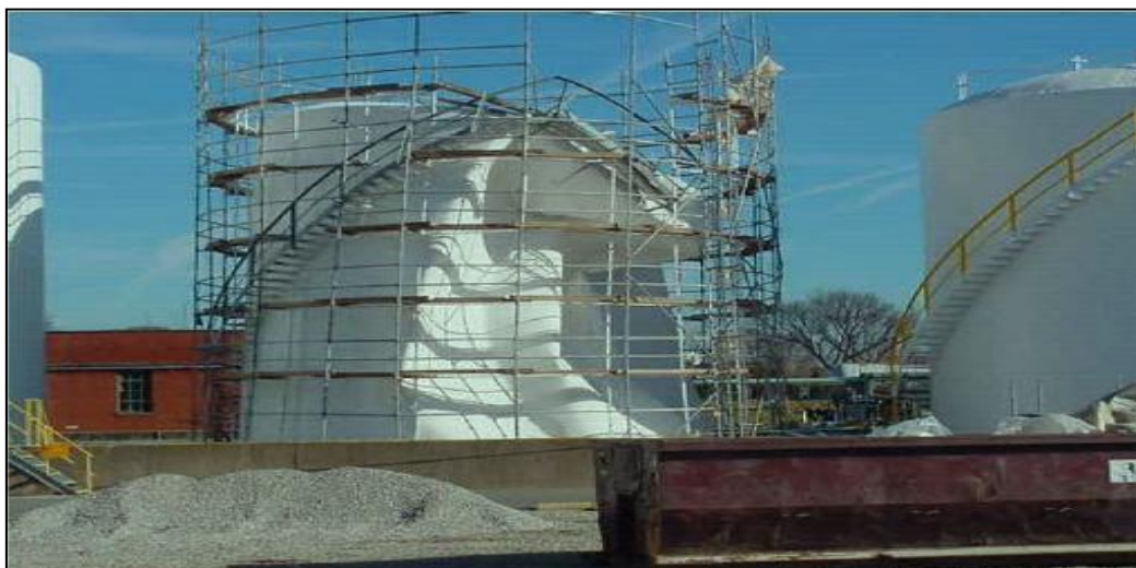
Figura 4.4. Colapso de tanque de almacenamiento debido presiones negativas ( http://cyvsa.com.mx/pdf/protecciondetanquesatmosfericos.pdf )
