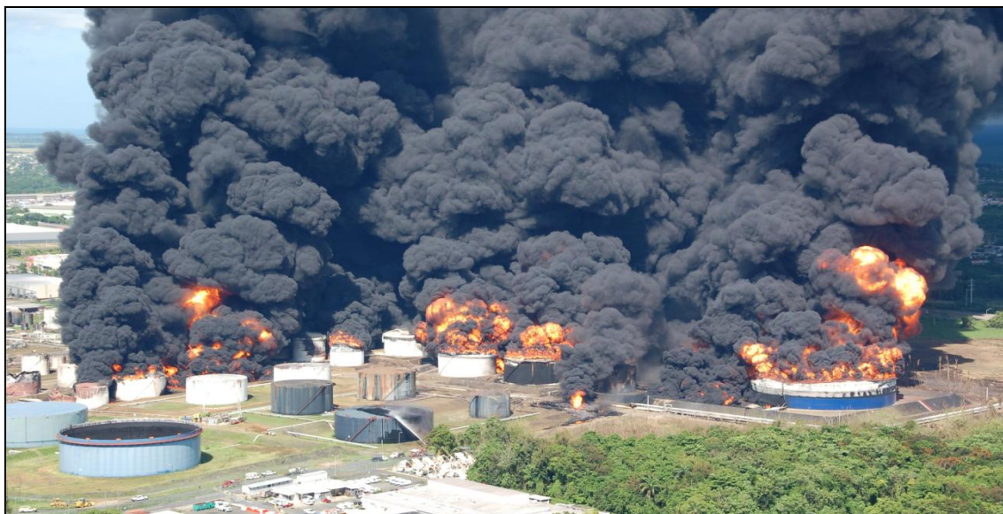
Figura 4.3. Incendio en patio de tanques.( http://www.dk1250.com )
