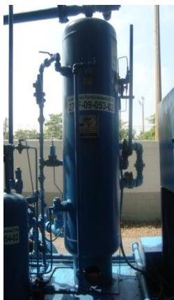
Figura 4.18. Separador vertical del equipo no convencional.
