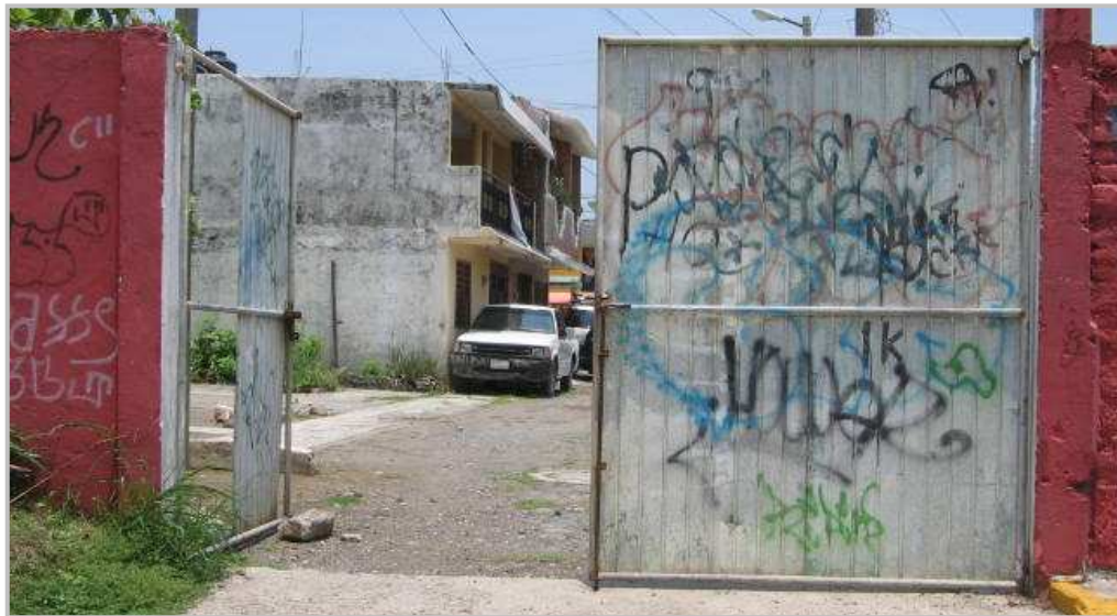
FIGURA 66.- Puerta trasera de acceso.
