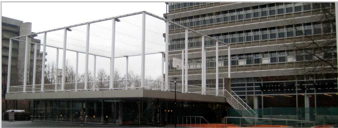
FIGURA 34.- Vista general del Basketbar.
