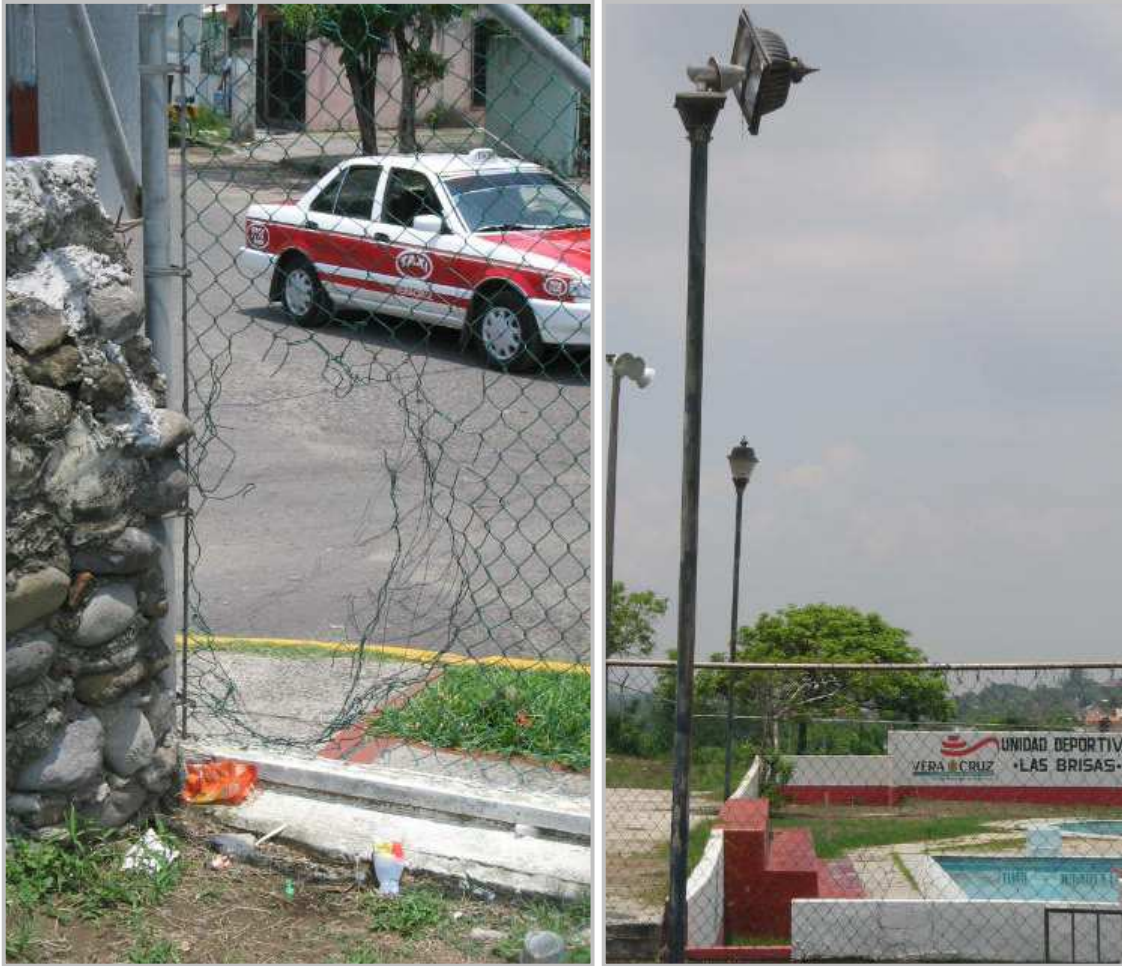
FIGURA 63.- Falta de mantenimiento y descuido de las instalaciones.
