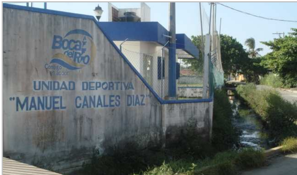
FIGURA 54.- Vista exterior de la unidad deportiva, ubicada a un costado de un desagüe de aguas negras.
