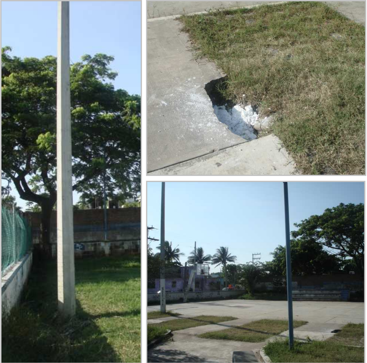
FIGURA 59.- Áreas verdes en descuido y deterioro en mobiliario urbano.
