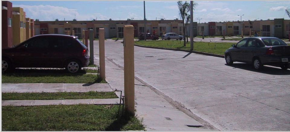
FIGURA 80.- Calles de concreto.
