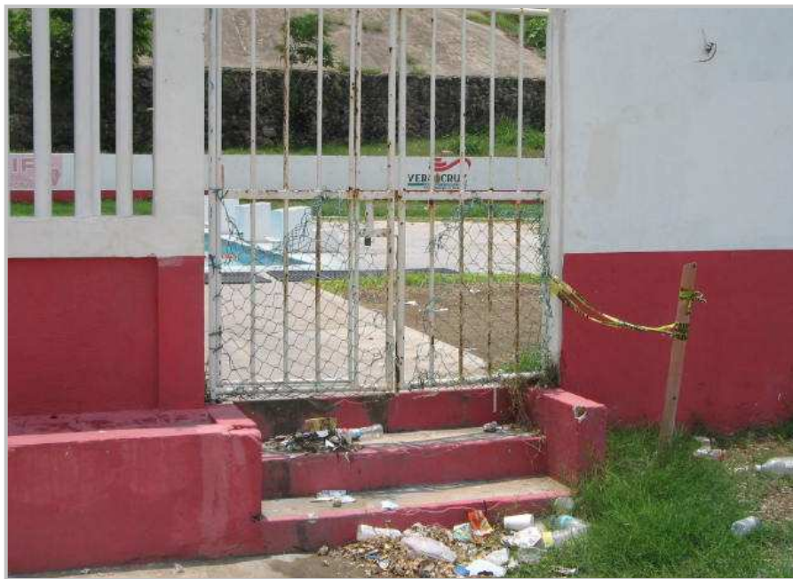
FIGURA 62.- Acceso principal a la unidad.
