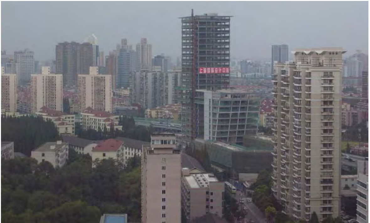
Ilustración 25- Fotografía de la construcción del centro de diseño de la Universidad de Tongji.
