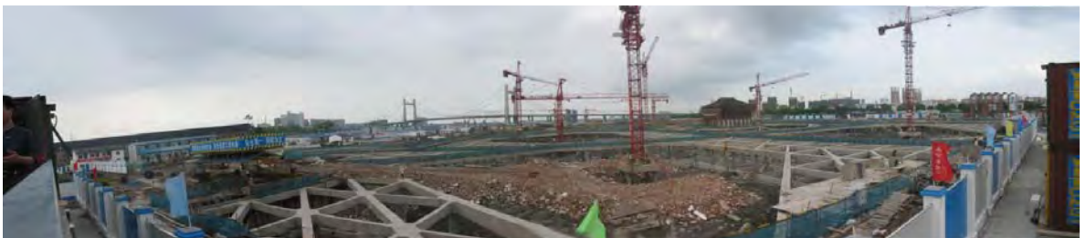
Ilustración 22- Foto panorámica del sitio de la construcción.
