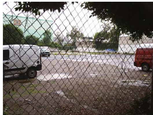
Malla ciclónica (fachada principal).
