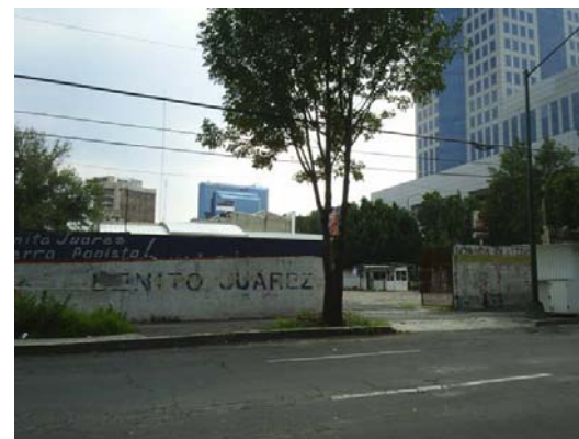
Barda de tabique gris (fachada lateral y posterior).
