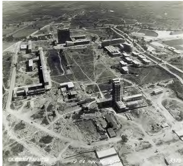
Construcción de Ciudad universitaria, 1951.
