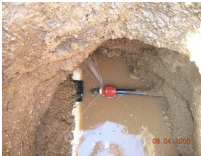
Figura 2.40 Fugas en la red de distribución
