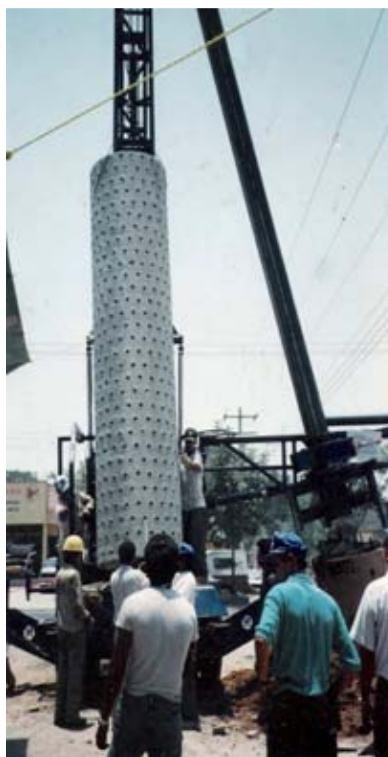
Tomada por: Ing. J.M. Vargas Sánchez † Figura 4.8 Instalación de un Pozo de infiltración
