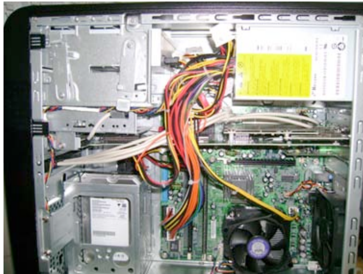
Figura A7. Tarjeta NI PCI-5152 instalada en una PC.
