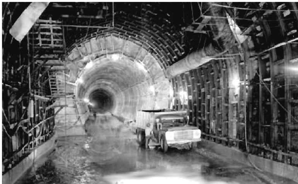
Ilustración 16.- Una de las galería del drenaje profundo inaugurado en los años 70s.
