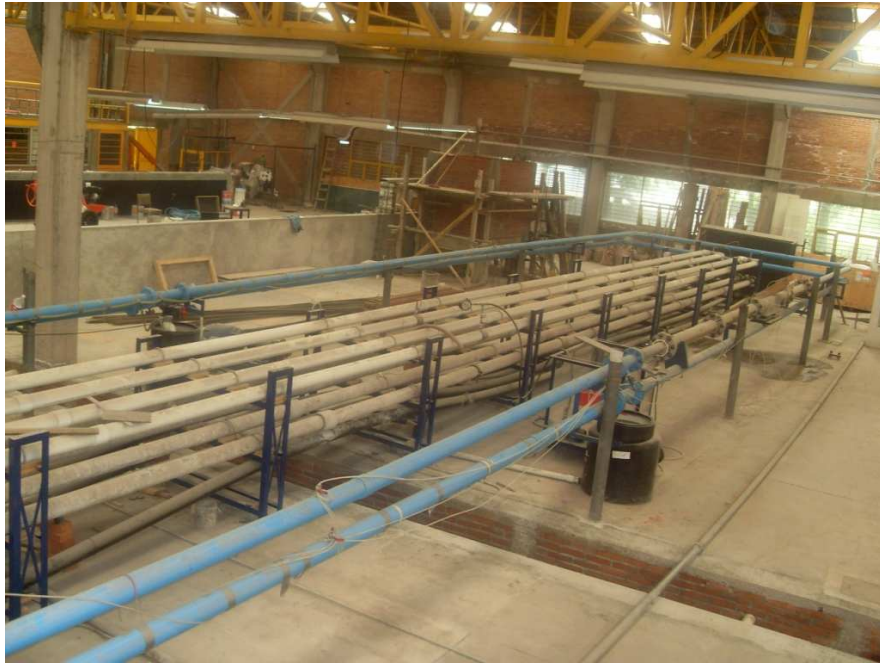
Figura 2.1: Vista lateral del ducto
