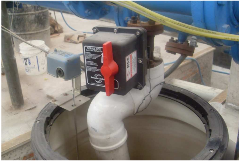
Figura 2.7: Servo-válvula
