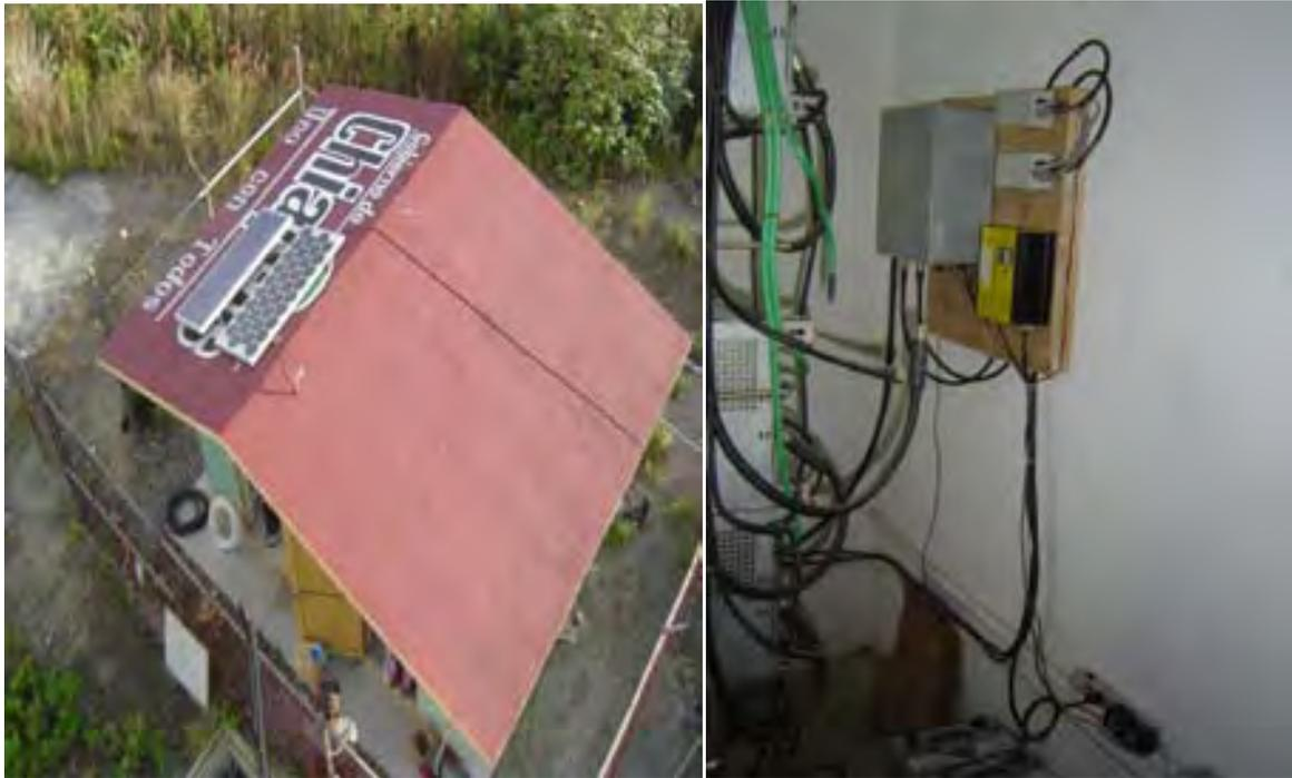
**Figura 36.** Equipo para el envío de datos, distribución de carga y abastecimiento de energía eléctrica (Cortesía del Dr. Carlos Valdés González).
