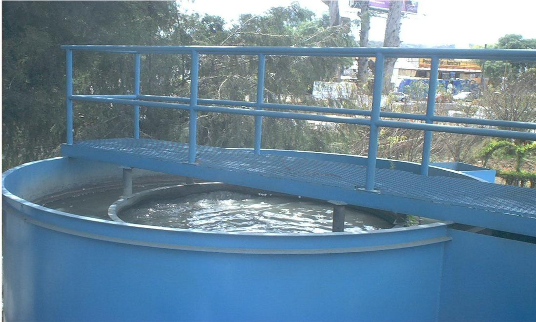
**Fig.8.5** Desarenador de la planta de tratamiento de Naucalpan
