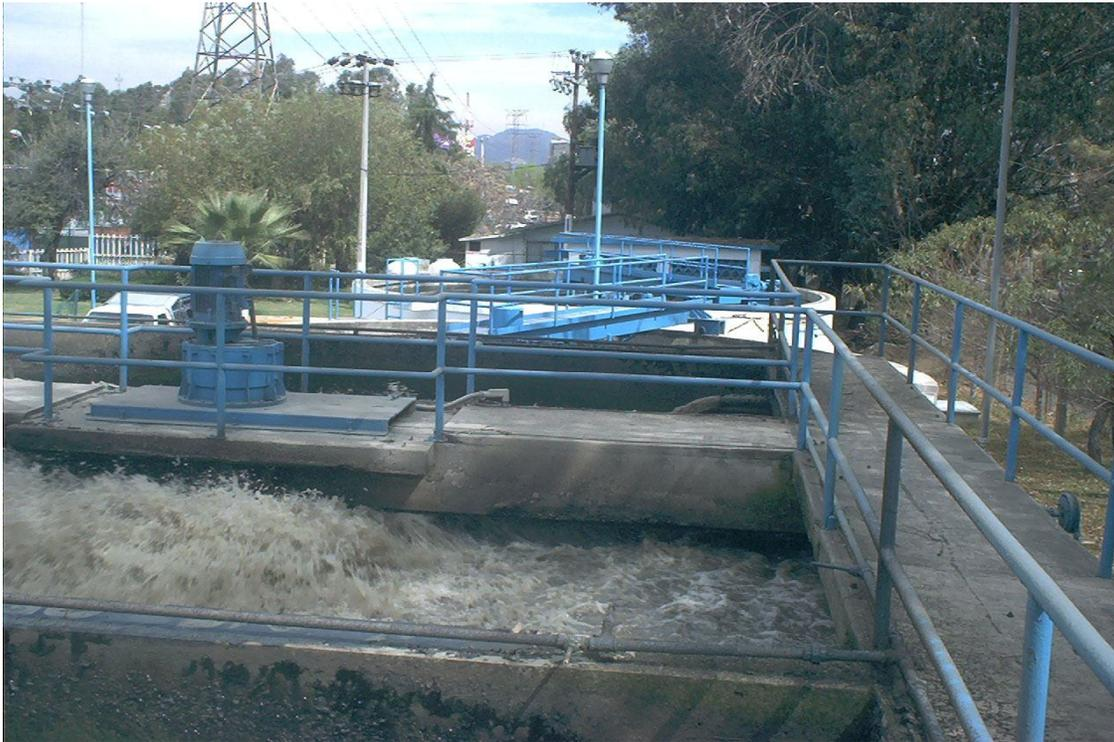
**Fig.8.6** Aireador de turbinas, planta de de tratamiento de Aguas muestreada.
