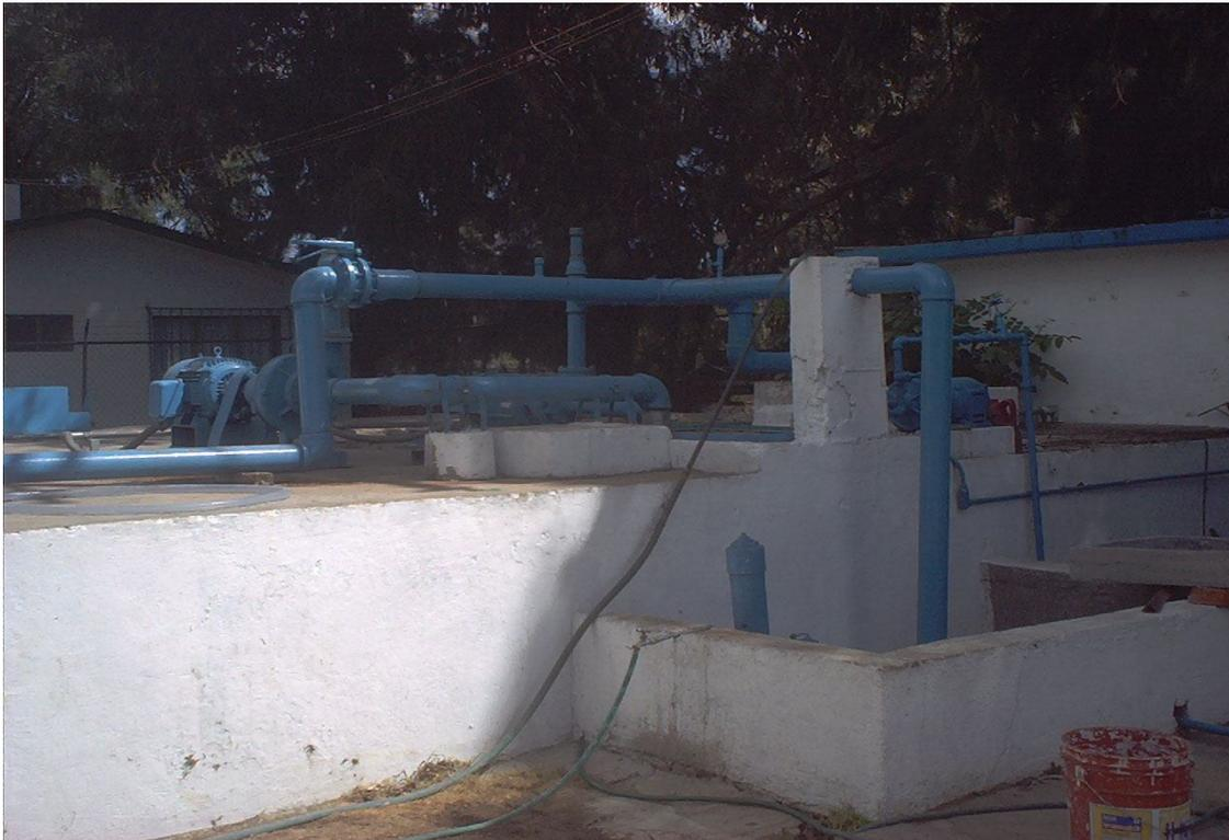
**Fig. 8.9** Cisterna de Almacenamiento de Agua tratada.
