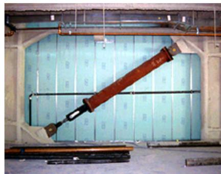
Amortiguador viscoso instalado en la estructura.
