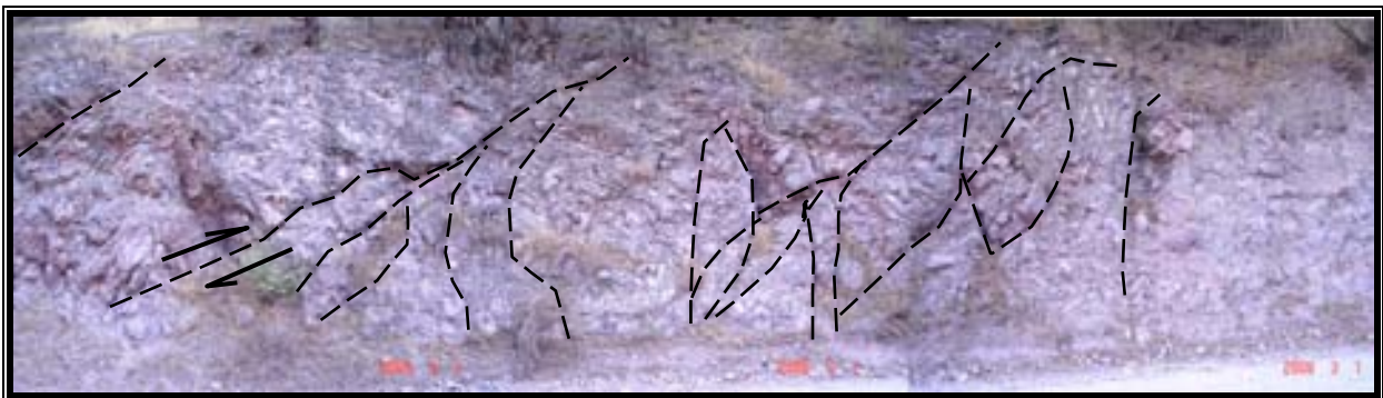
Figura 65.- Zona de falla con estructuras sigmoides rotadas y brecha de falla.
