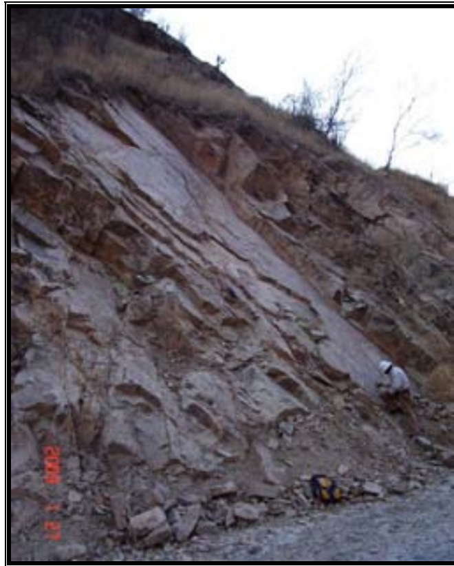
Figura 93.- Detalle de los planos de deslizamiento de la falla.
