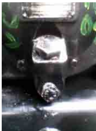
Purga del desaceitador
