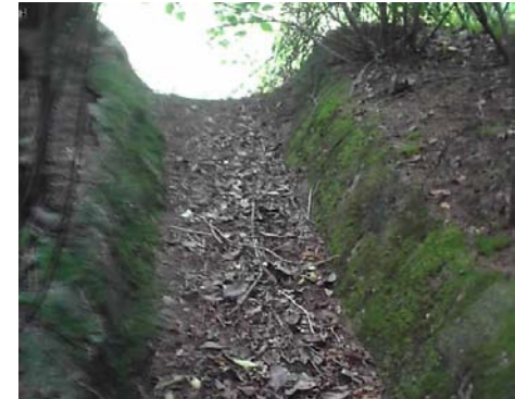
Canaleta para desalojar el agua pluvial que entra en el terreno
