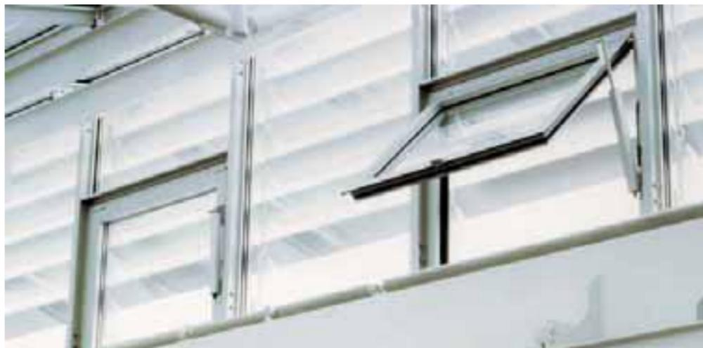
Sistema de apertura y cierre de ventanas de ventilación
