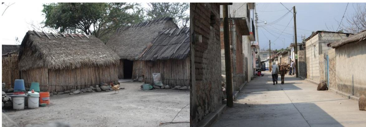
Figura 1.6. Sustitución de los materiales de construcción en las viviendas de Cuentepec. a. Palma y carrizo. b. Adobe y concreto.
