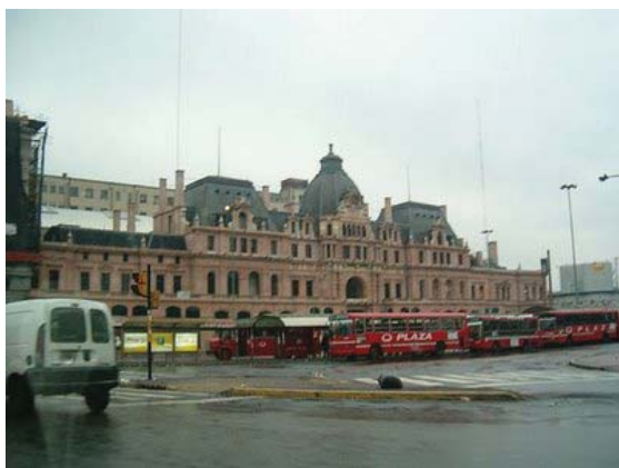
VISTA GENERAL ESTACIÓN CONSTITUCIÓN
