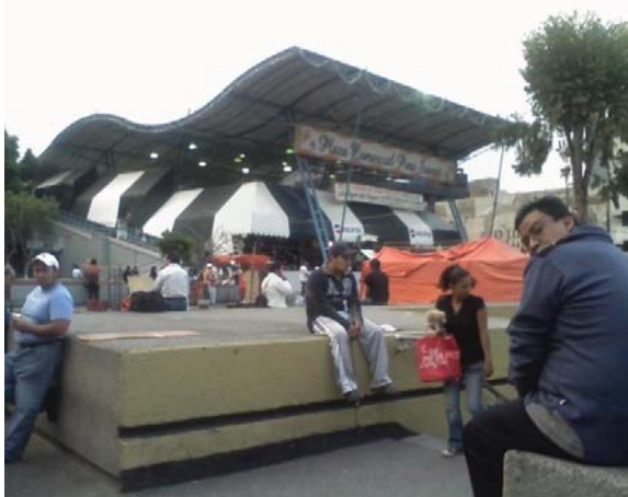
VISTAS GENERALES DEL CORREDOR COMERCIAL
