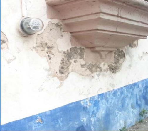
**Diagnóstico:** Se encontraron rastros de sales, en muros del edificio original, pero la humedad concentrada en el agregado tres ocasiones la salida de sales en el muro bajo. Es el único caso no afecta la estructura del edificio solo el acabado.
