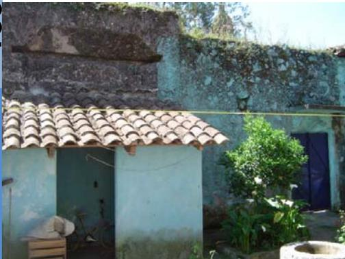
LOS DAÑOS POR OXIDACIÓN SE LIMITAN A LAS PUERTAS Y VENTANAS NO AFECTAN EN NINGÚN MOMENTO A LA ESTRUCTURA, DEBE ENTENDERSE QUE ESTAS HERRERÍAS NO PERTENECEN A LA CONSTRUCCIÓN ORIGINAL.
