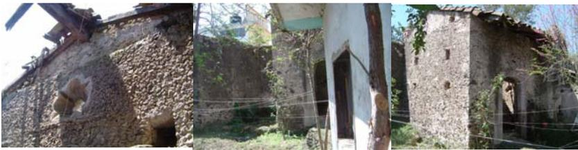
**Diagnóstico:** En cubiertas no se presentan ningún tipo de deformación ni en muros de las construcciones principales, sin embargo en techos que limitan el jardín hacia la calle mejía se presenta se p`resenta la pérdida de la techumbre en algunos locales, provocado por la falta de mantenimiento y la lluvia
