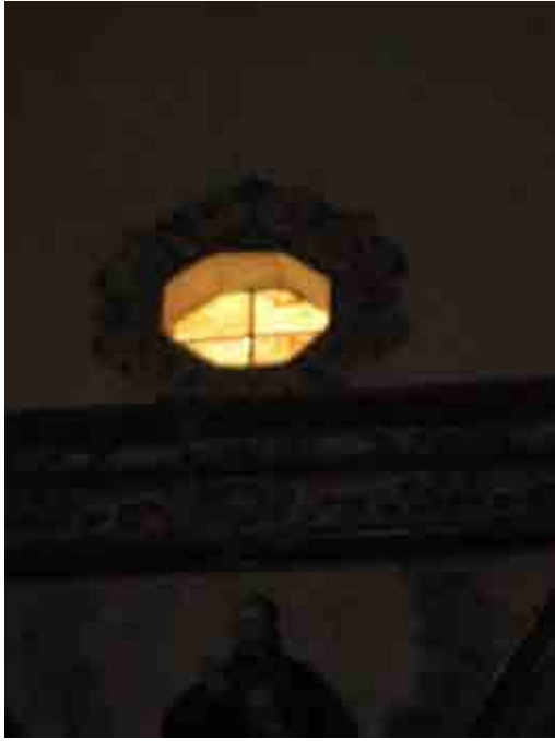
Orificio de la ventana sureste de la cúpula del crucero, ex templo de San Francisco Javier, Tepotzotlan
