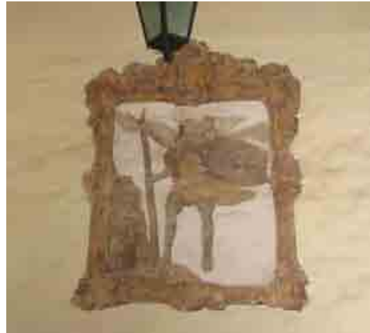
Imagen del Arcángel San Miguel, Muro cara sur entrada al interior del convento franciscano, (cara sur) Tlax, Tlax. S.XVI
